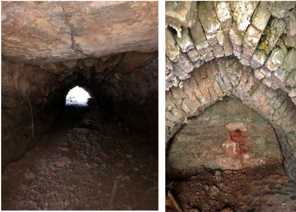
Fig. 4. Comparativa entre la solución adintelada y bóveda de aproximación de hiladas del caz en su tramo A con el interior de la cámara de combustión del tejero del barranco del Hocino (Fuente: elaboración propia).
