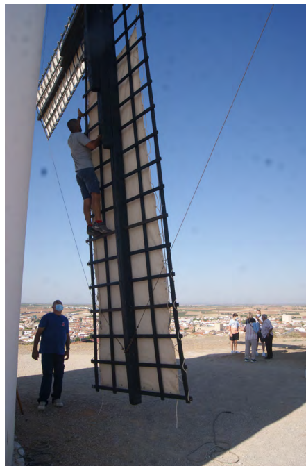
Figura 4. Colocación de las velas en el molino de Mota del Cuervo para molienda tradicional.
