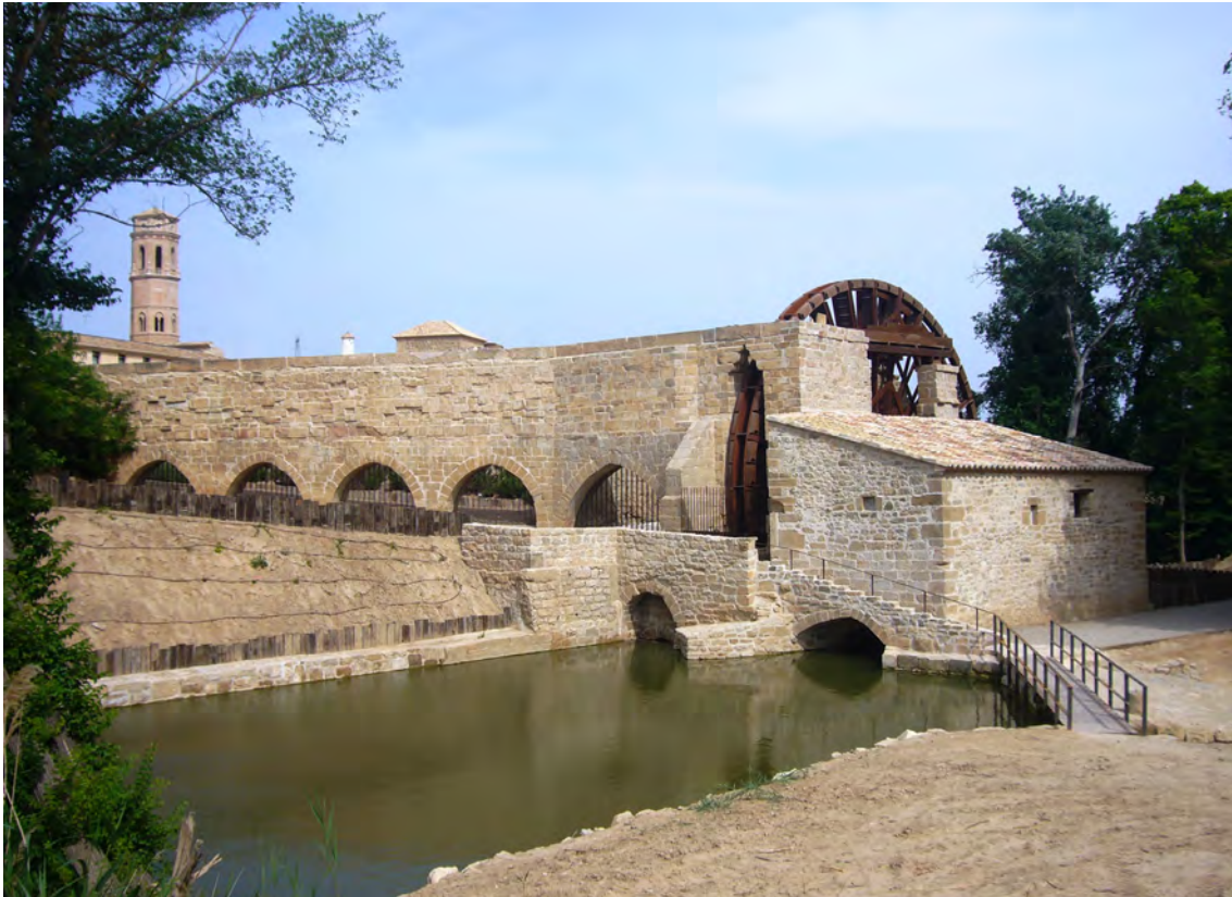
Imagen 3. Vista general del conjunto hidráulico. Autor: Javier Ibargüen Soler.
