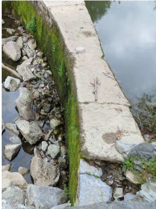
Fig. 4. Extremo izquierdo, julio de 2016. Espacio de 200 cm con la falta de losas. Corresponde a dos dovelas completas y parte de otras en ambos costados. Se aprecia alguna falta de material de macizado del cuerpo tras ellas. (fotografía del autor)
