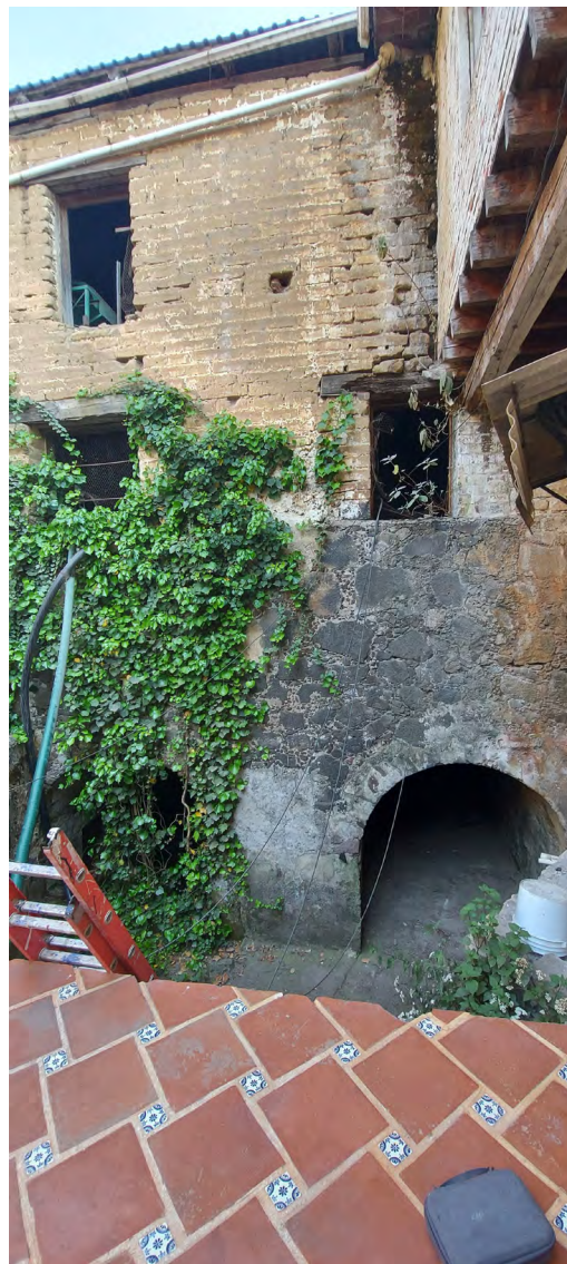
Fig. 5. Fachada del Molino de Ayapango en 2021. Se observan los dos cárcavos del molino de Ayapango y las ventanas de vigía. Fotografía de Hector Perea Chairez.
