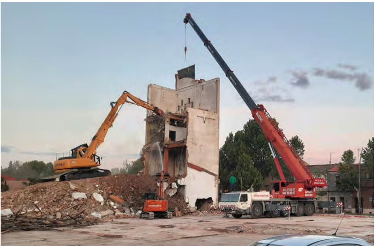
7. Imagen de la demolición desde el aparcamiento de "La Perla". Fotografía del autor
