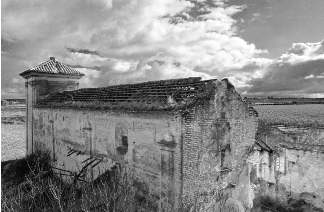
Imagen 4. Vista lateral del Molino Charcón (Écija). En este se distinguen los muros de tapia de fraga con encadenado de ladrillo con verdugada triple y la cubierta de par y nudillo de la nave almazara así como la torre de contrapeso de ladrillo y su cubierta a cuatro aguas. Fotografía: el autor 2020.
