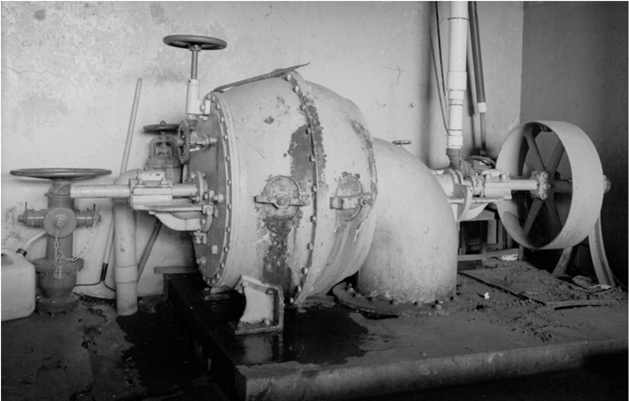
Imagen 2. Turbina Francis. Fotografía por los autores en Beneficio Patalillo. Tres Ríos, Cartago, 2019.
