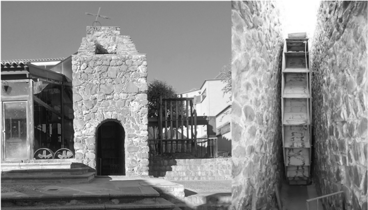
Fig. 2. Izquierda: Cárcamo del ingenio San Marcos, restaurado y puesto en valor como Museo Café. Nótese a la derecha la estructura de madera denominado castillo, con el eje horizontal de madera y las almadenetas. Derecha: La rueda hidráulica, al interior del cárcamo. Ciudad de Potosí. Fotografía propia.
