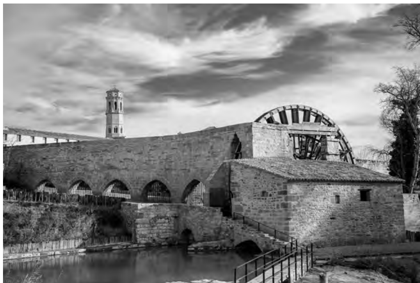
Figura 1. Las norias se mantuvieron hasta la segunda mitad del siglo XX pese a su laborioso mantenimiento, porque atendían a notables superficies de regadío. Noria y molino de regolfo del monasterio de Rueda en Escatrón (Zaragoza) Fotografía: Carlos Blázquez
