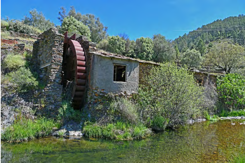
Figura 6. El molino de aceite de Asegur, con su soberbia rueda vertical gravitatoria.
