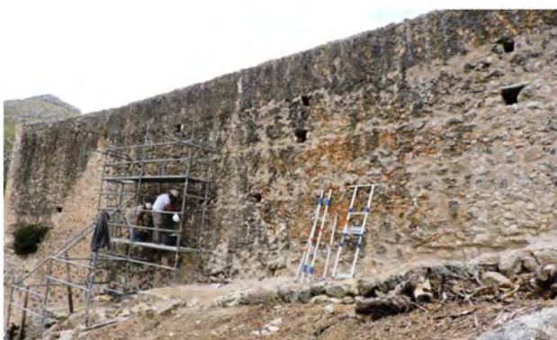
Rejuntado selectivo del muro del primer molino
