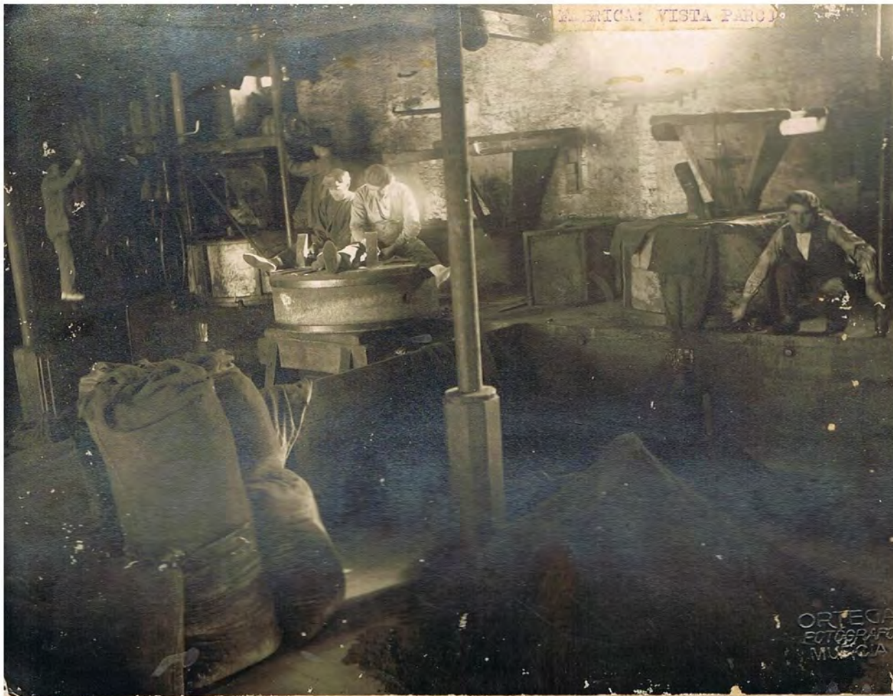
Imagen 5. Trabajadores del molino realizando el mantenimiento de las piedras. Fuente: Archivo fotográfico familia Armero.
