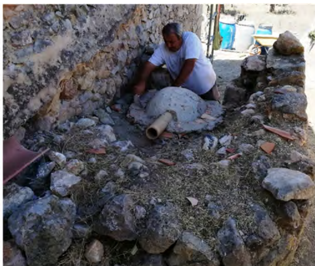
Restauración del horno de pan
