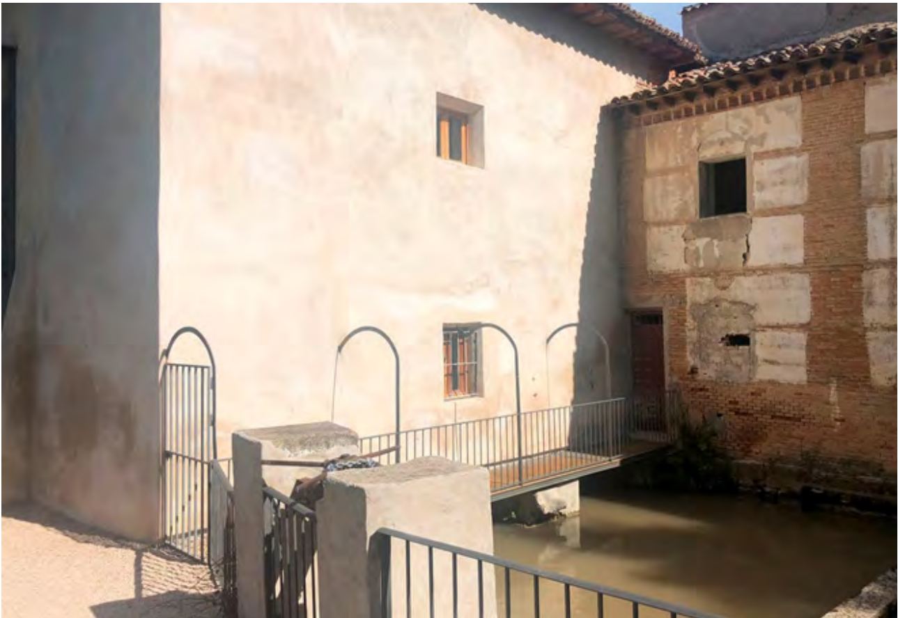
5. Muro trasero del cuerpo central tras su reparación. Fotografía tomada por los autores.
