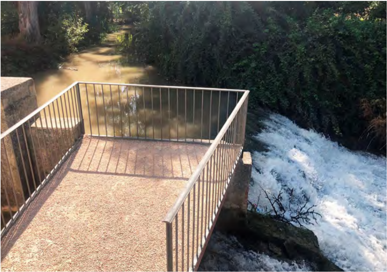
7. Nuevo mirador sobre el azud del Molino. Fotografía tomada por los autores.
