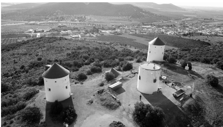
Vista de los molinos de Puerto Lápice, con el del Bachiller Sansón Carrasco en el centro, durante los trabajos actuales de rehabilitación . (Foto cortesía de Gema Garrido Resino).
