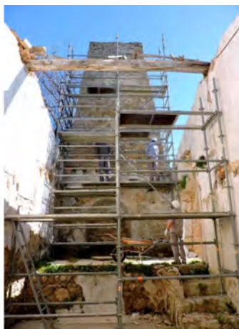
Rejuntado selectivo del cubo del segundo molino
