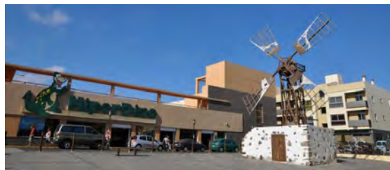
Figura 5. Molino de viento entre edificios y viales. TM de Corralejo. Isla de Fuerteventura. Fuente: AirtagAlex. https://lh5.googleusercontent.com/p/AF1QipNRjhNZAiuPw0lzG68ozE59bXvHr5t3v6R5oN=w1280-h720-pd
