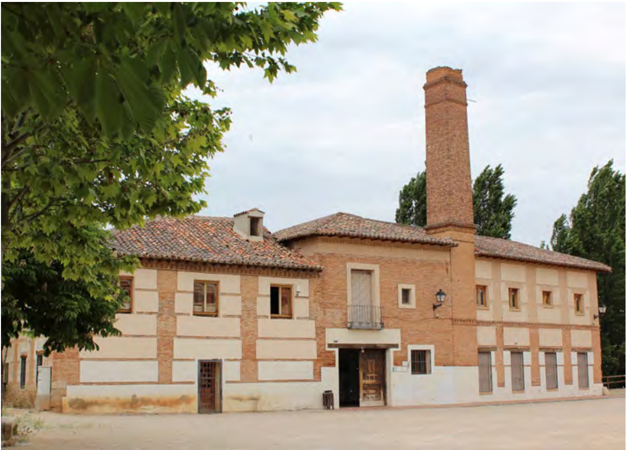
1. Fachada principal del Molino de la Huerta. Fotografía tomada por los autores.
