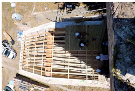
Construcción del cañizo sobre la cubierta del segundo molino
