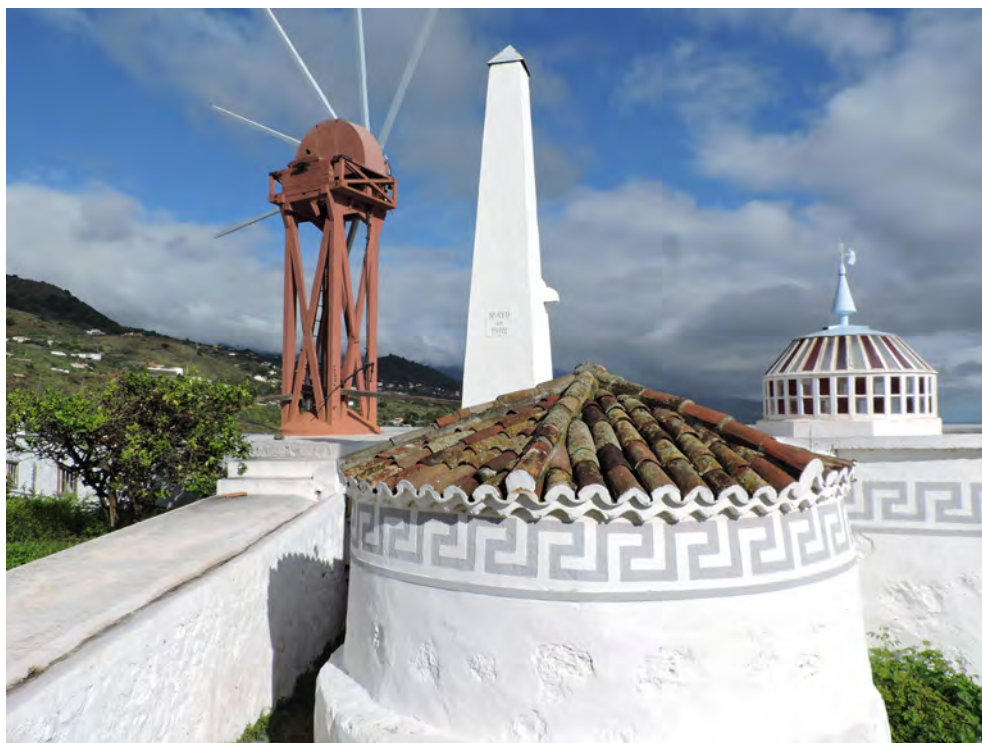
02 Cubierta del molino, obsérvese el lucernario en el que se ubicó la segunda torre de pruebas
