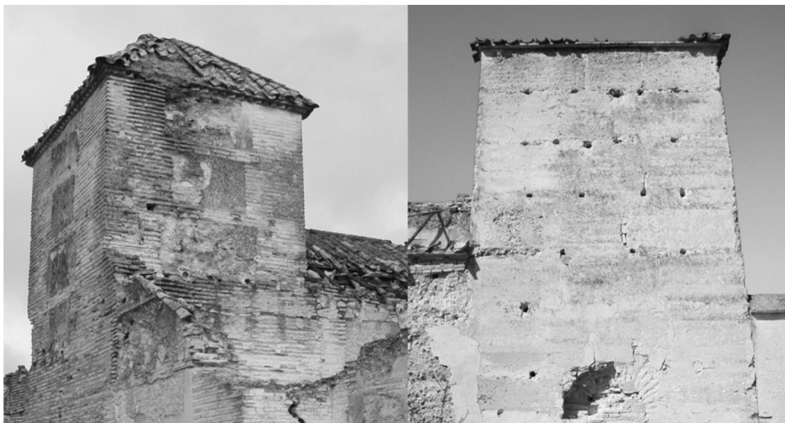
Imagen 6. Torres de contrapeso de los molinos de la Atalaya Alta (izquierda) y del molino de Pareja (Écija). En la primera se aprecia una solución constructiva del cuerpo superior mediante tapia verdugada de fraga con machones de ladrillo en las esquinas, tipología más común de las torres de contrapeso ecijanas, mientras que la segunda solución muestra el cuerpo superior resuelto con tapia simple monolítica, la tipología menos frecuente junto a la de mampostería de piedra. Fotografía: el autor 2020.
