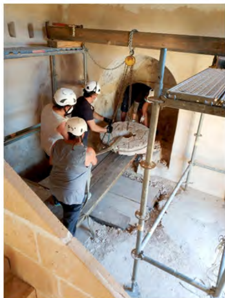
Desmante de las muelas, obrador del segundo molino
