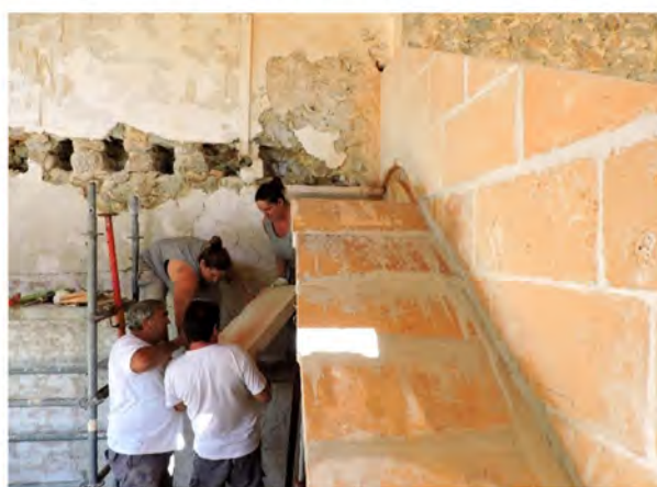
Construcción de la rampa de escalera, obrador del segundo molino
