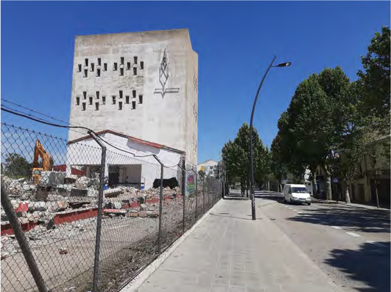
1. Calle Francisco Artilo 12, previa a la demolición de la torre. Fotografía del autor
