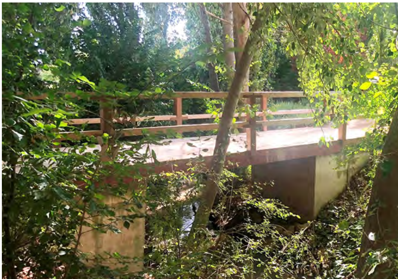
6. Nuevo puente de hormigón sobre el canal. Fotografía tomada por los autores.
