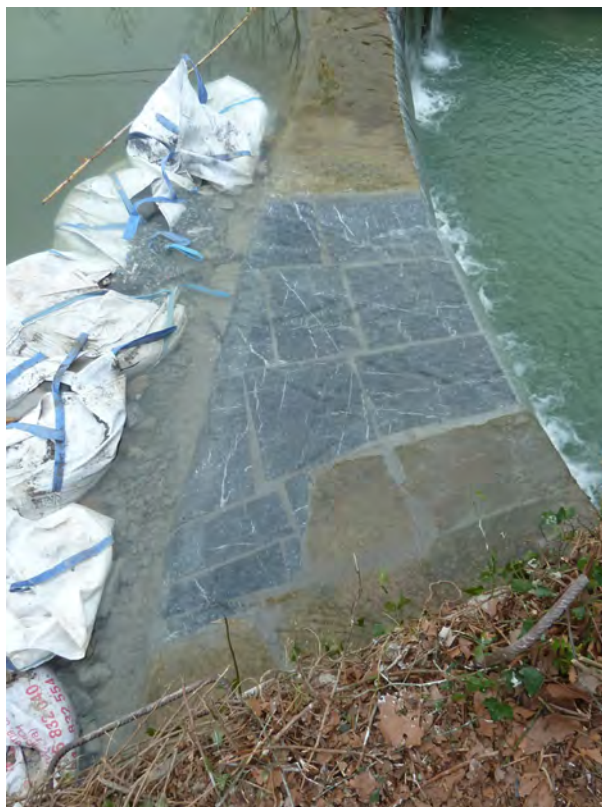
Fig. 5. Nuevas losas de coronación colocadas en el extremo del arco derecho. (fotografía del autor)
