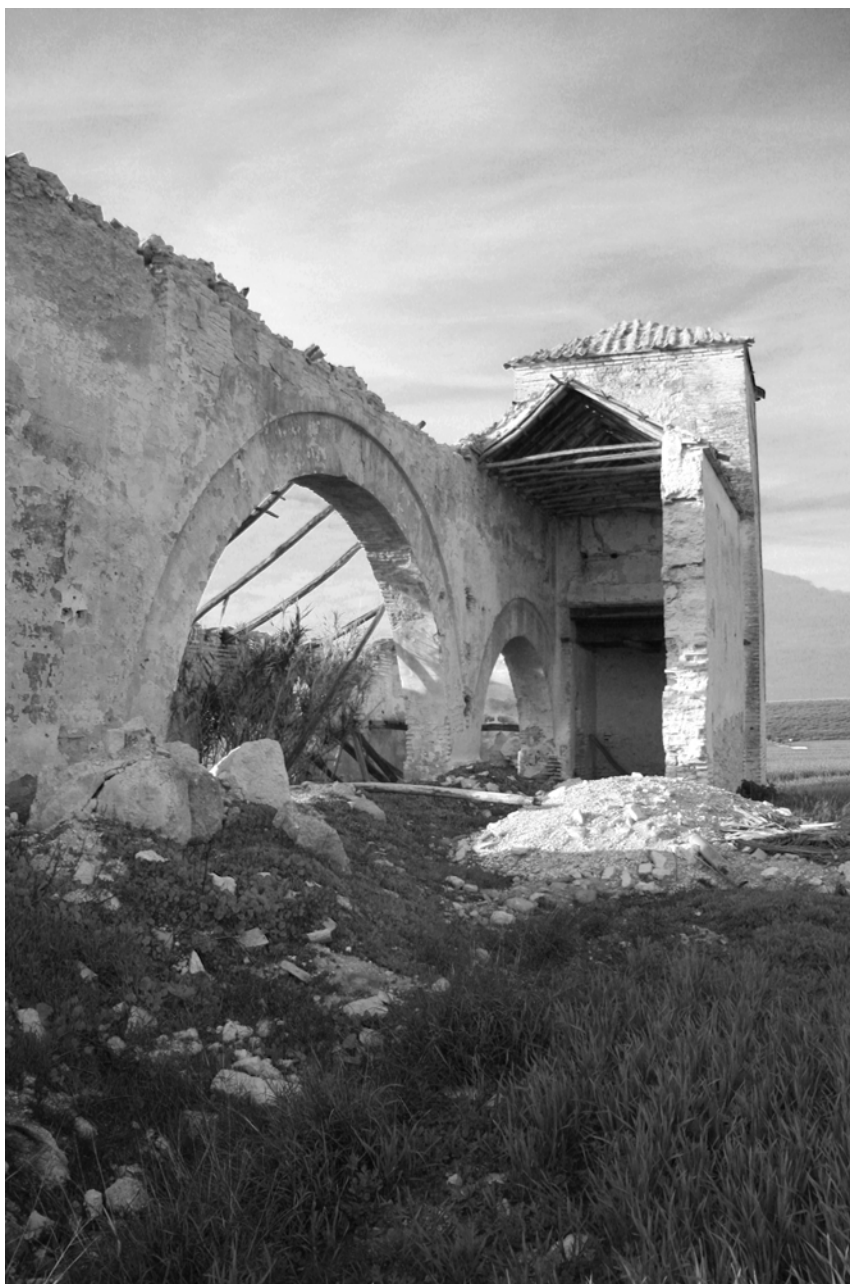
Imagen 5. Molino del Gallego (Écija). En esta vista se aprecian los arcos de ladrillo pertenecientes a la partición entre la nave de la viga y de la molturación. Además se aprecia la cubierta de par e hilera de la nave de viga y algunos pares de la cubierta a un agua de la nave de molturación, así como la torre de contrapeso con su cubierta a cuatro aguas característica. Fotografía: el autor 2020.
