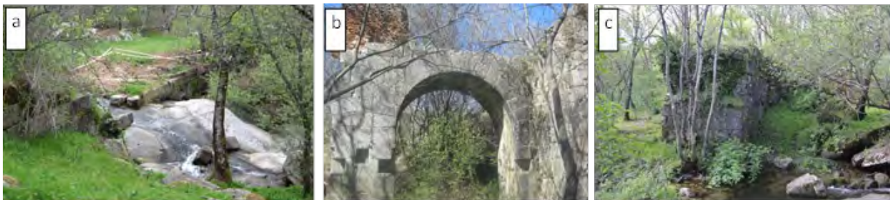
Figura 2. Restos físicos del Molino Caído (2a: Restos de la presa del Molino Caído. 2b: Arco, fábrica de ladrillo y pared del cubo hidráulico del Molino Caído. 2c: Terraplén de sillarejo en el margen derecho del río) (fuente propia).
