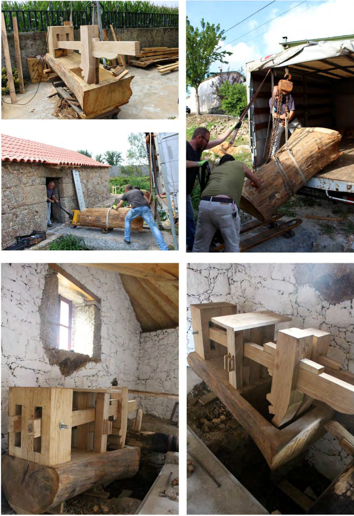
Imagen 5. Proceso de ejecución, montaje e instalación del batán de golpe Vertical. R. Bruno Matos, (2019).
