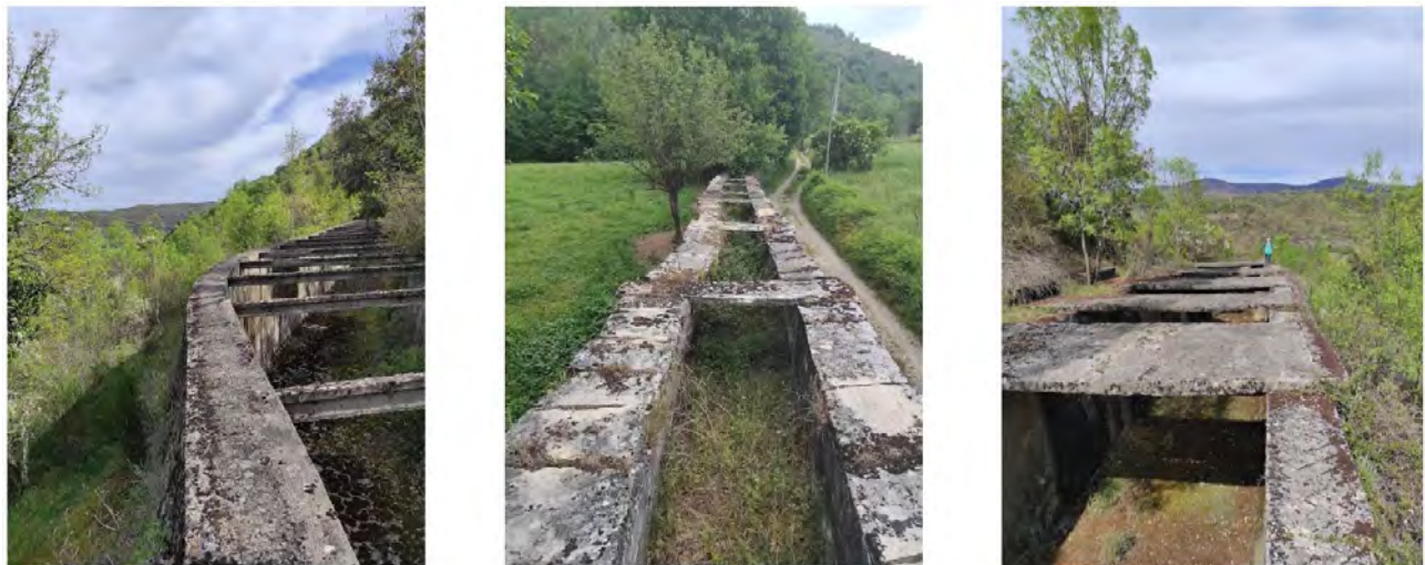
Figura 8. Soluciones de arriostramiento de cauces de saltos forzados. A izquierda y derecha, dos tramos del canal del Salto nº 1 de Hidrogalicia (1948-58 ca.); en el centro, banzadillo del molino de Portela de Valcarce. Fte.: J. Magaz-Molina.
