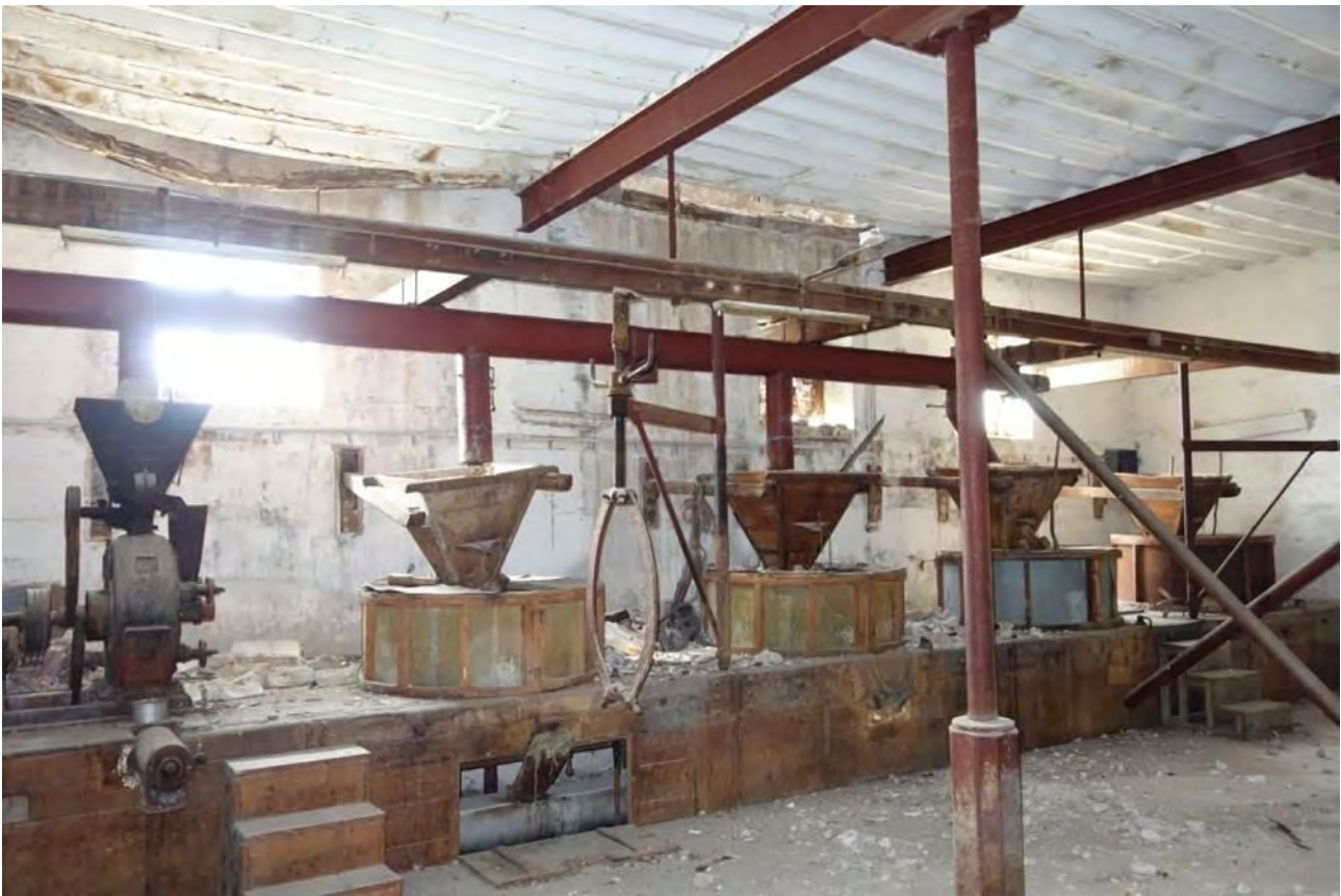
Imagen 4. Sala de molienda principal. En la imagen, cuatro piedras con tolva y guardapolvos, grúa y conductos para la circulación del pimentón. Fotografía de Alicia Sempere Marín.
