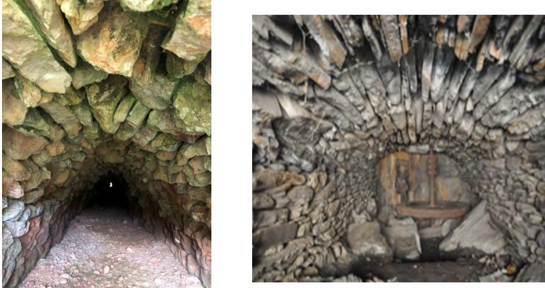
Fig. 5. Comparativa entre el tramo B y la cimbre de piedra seca del cárcavo de un molino de Castro de los Filabres 11 (Fuente: elaboración propia).
