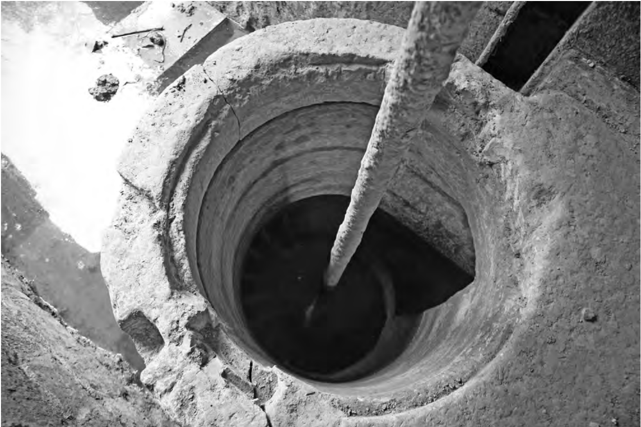
Figura 2. Accionamiento de regolfo del Monasterio de Rueda, donde se puede apreciar el rodete, los encajes para la tapa y los topes para evitar el giro. Fotografía: Carlos Blázquez
